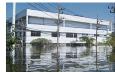
3mの水に浸かったメディカル工場
