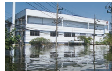
医药工厂被浸在3米深的水中
