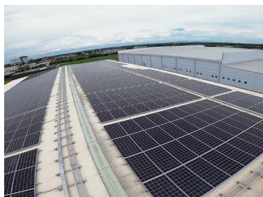
セブ工場での太陽光パネルの設置
