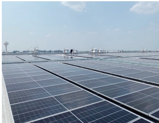
タイ工場での太陽光パネルの設置
