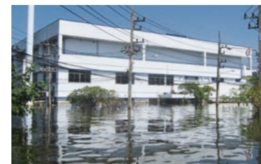
医药工厂被浸在3米深的水中
